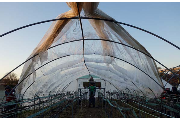
Fot. 6. Folię na konstrukcję najlepiej zakładać w bezwietrzne dni
