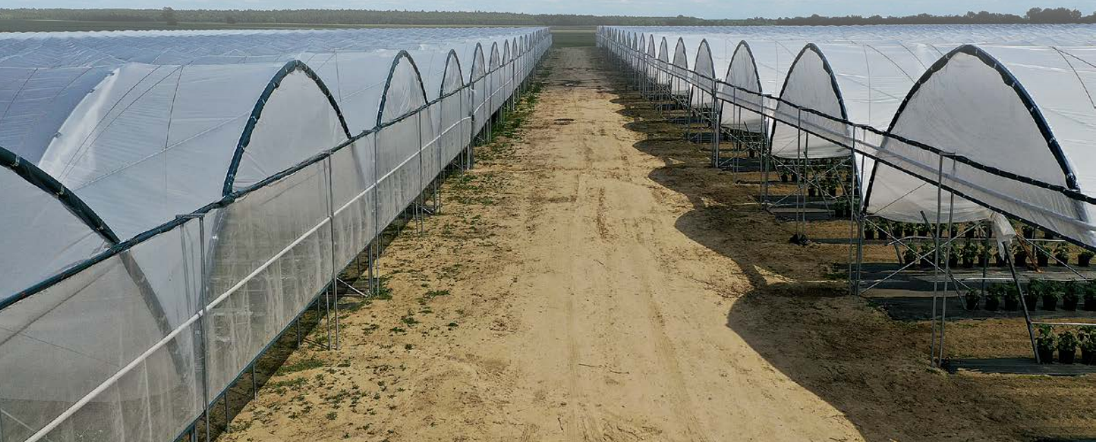
Fot. 3. Typowe tunele wielonawowe (zblokowane) o kształcie gotyckim
