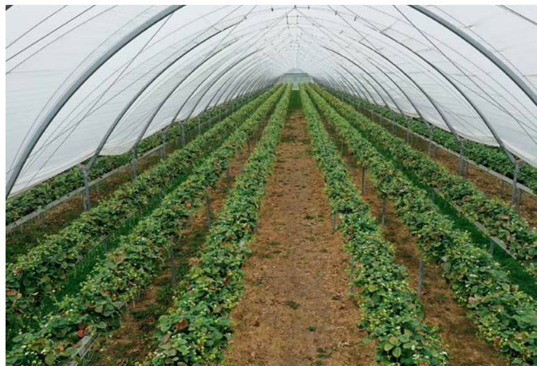
Fot. 3. Wręgi mają kształt gotyki i wykonane są z rury „owalnych”
