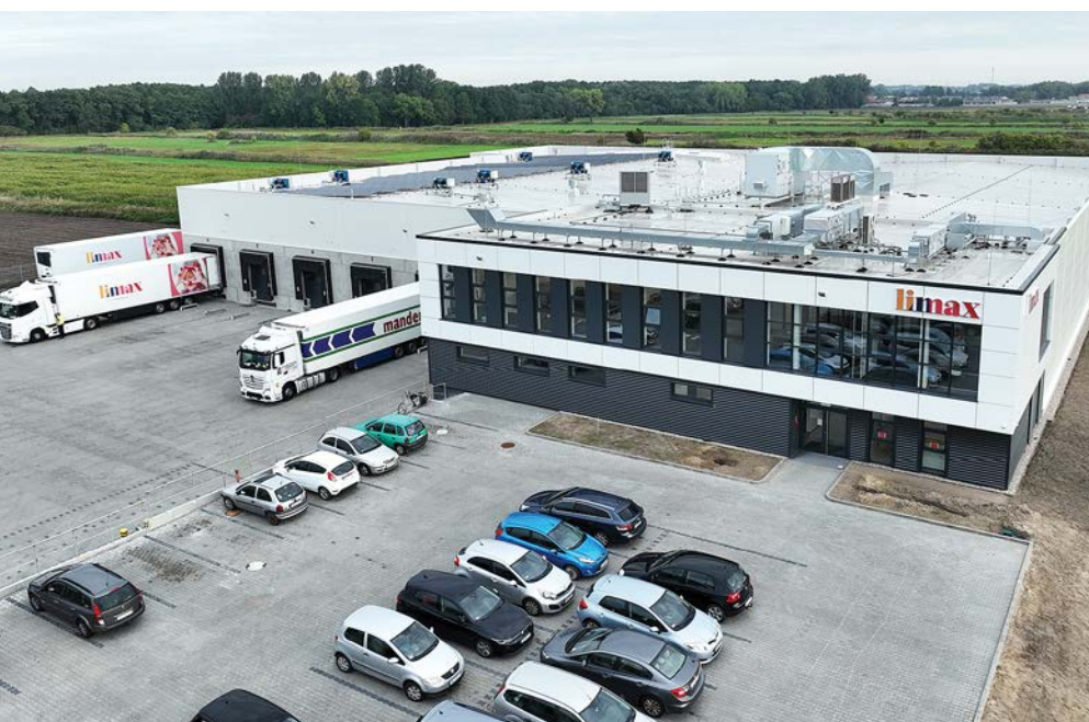
Fot. 7. Obiekt logistyczny uruchomiony w 2022 roku
