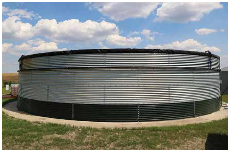
Fot. 2. Zbiornik do magazynowania wody, z systemem jej wstępnego zakwaszania
